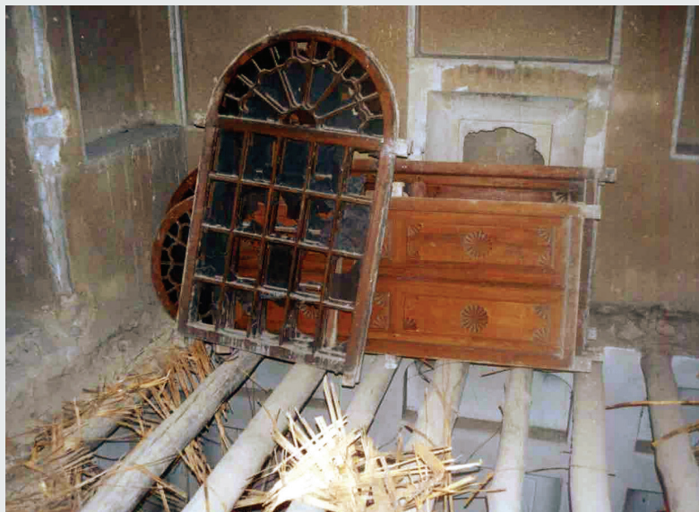
Interior de la casa de Mirza Abbas Nuri, un hito arquitectónico de Teherán, durante su demolición en junio de 2004.
